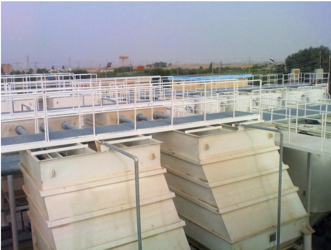
مخازن ته‌نشینی لاملا (Lamella Settling Tank)
