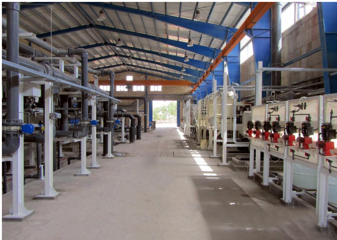
سالن آب شیرین کن از آب دریا با ظرفیت تولید 10,000 \text{ m}^3/\text{Day}
