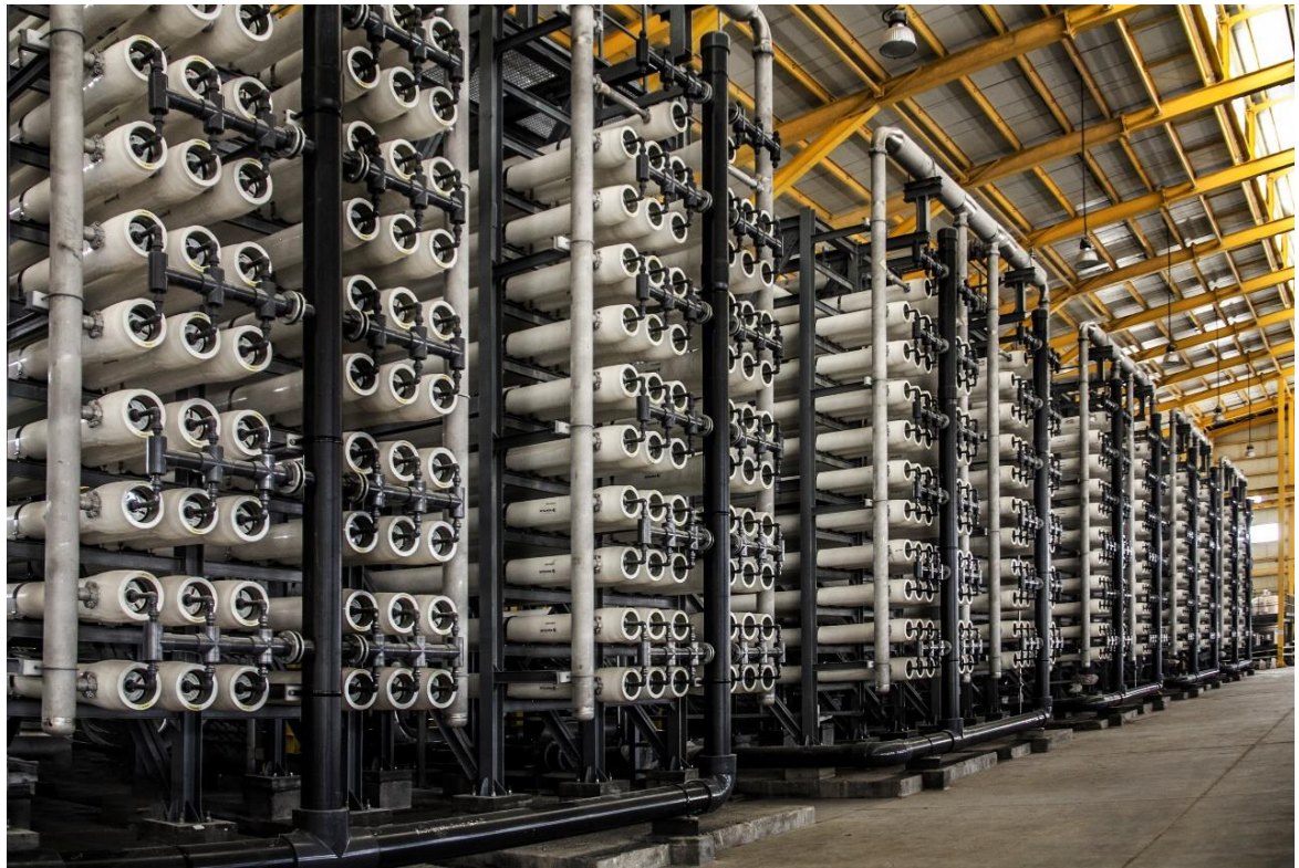
سالن آب شیرین کن از آب دریا با ظرفیت تولید 100,000 \text{ m}^3/\text{Day}
