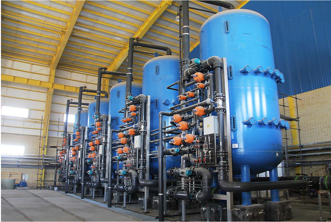
واحد تولید آب دَمین (TDS: 0.05 ppm) به ظرفیت 18,720 \text{ m}^3/\text{Day}
