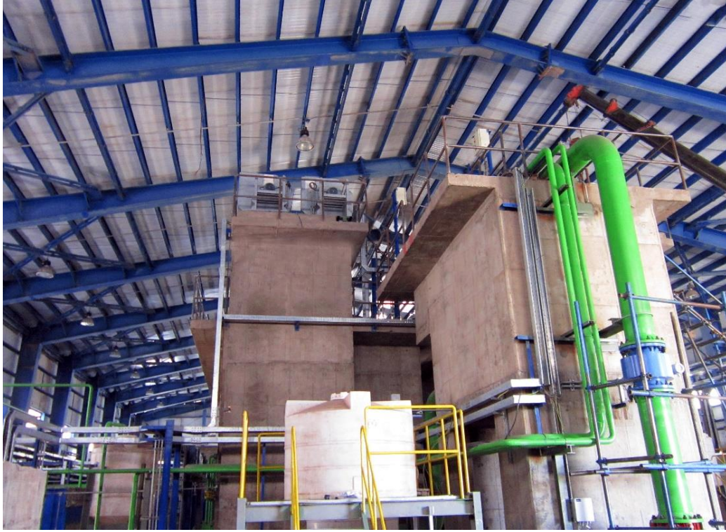
واحد پیش تصفیه ( سوپر پولساتور و فیلتر شنی ثقلی )
