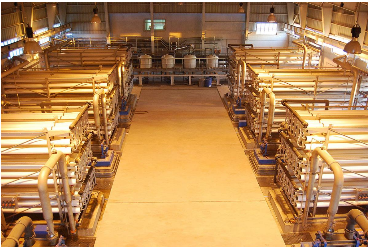
سالن آب شیرین کن از آب دریا با ظرفیت تولید 30,000 \text{ m}^3/\text{Day}
