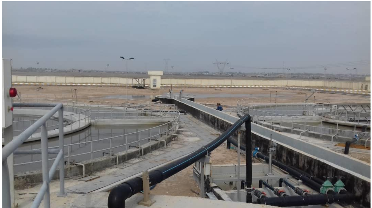
نمایی از حوض هوادهی و ته نشینی
