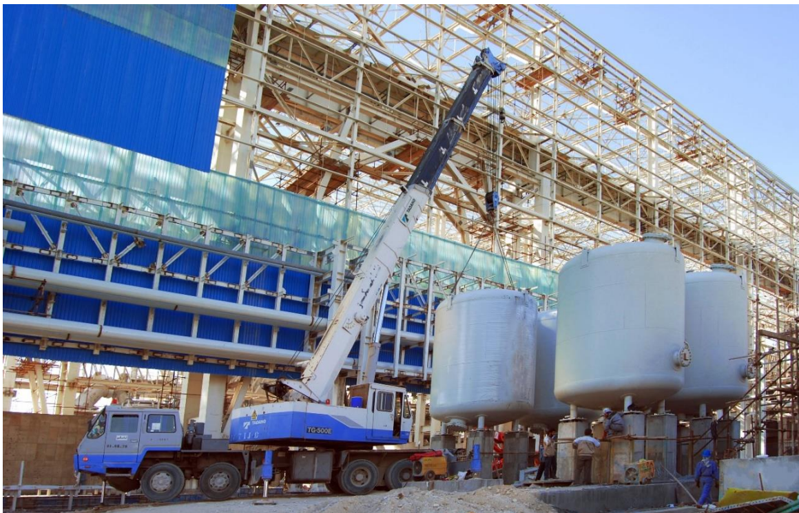
واحد برج‌های خنک‌کن به همراه فیلترهای جریان جانبی (Side Stream Filters)
