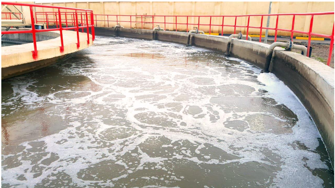
نمایی از حوض هوادهی و ته نشینی
