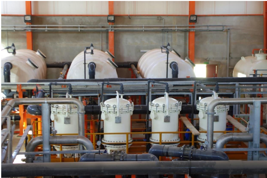
فیلترهای شنی تحت فشار و فیلترهای کارتریج
