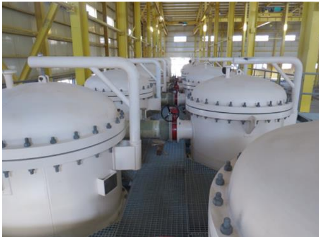
فیلترهای کارتریجی ۵ میکرون
